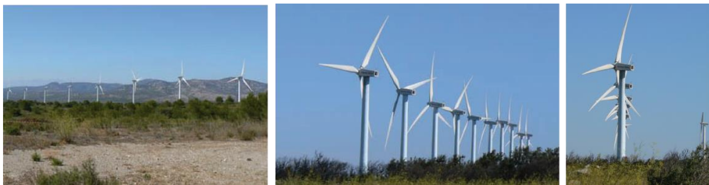
Photographie 90 : Perception selon l'angle de vue (Source : The Wind Power, auteur : Michaël Pierrot)
