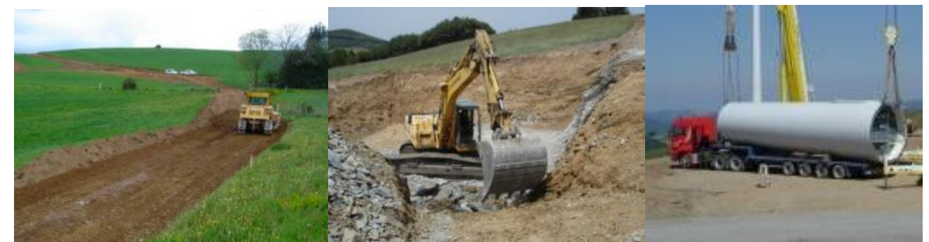
Photographie 91 : illustration d'un chantier éolien
